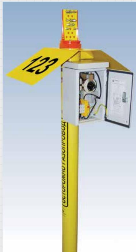
Клеммная панель КИП со стойкой круглого сечения
